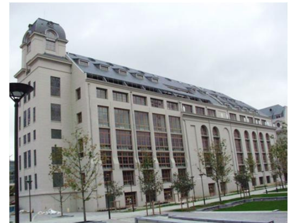
Bâtiment des Grands Moulins Université Paris Diderot-Paris7
